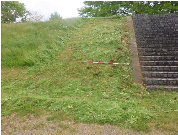
階段付近では大型機は幅寄せスイッチバックのため、安全確保に3m程度は肩掛け式で先行刈りし、刈草は集草～処分が必要 (緩傾斜の場合には大型機械で縦走行の例もあった)
