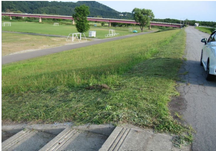
法肩や工作物回りは肩掛け式で先行刈り (最近、この部分も大型機械の例が多い)
