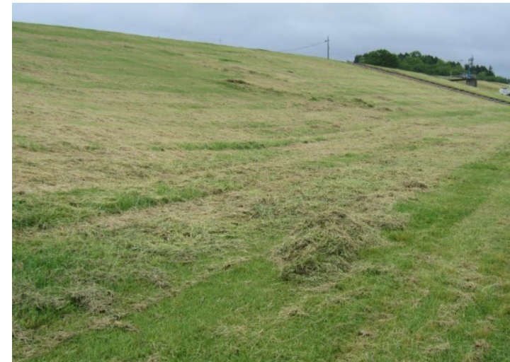
粉碎カッター式でも、刈草が丸まったり塊になる場合には、分散させる補助作業員を配置すべきと思われる (走行速度が速すぎると考えられる)
